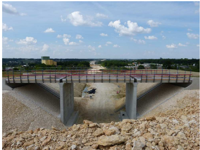
Construction du pont de "Ker Lucia"
