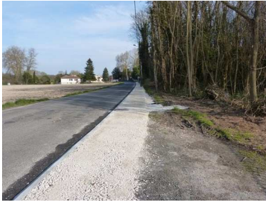
Aménagement trottoir Route de Pombreton
