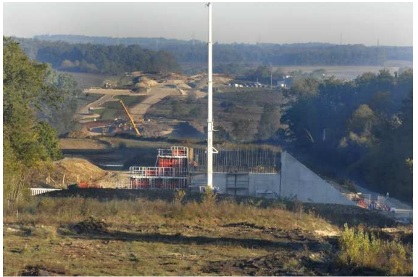
Photo travaux LGV sur la commune de Nersac
